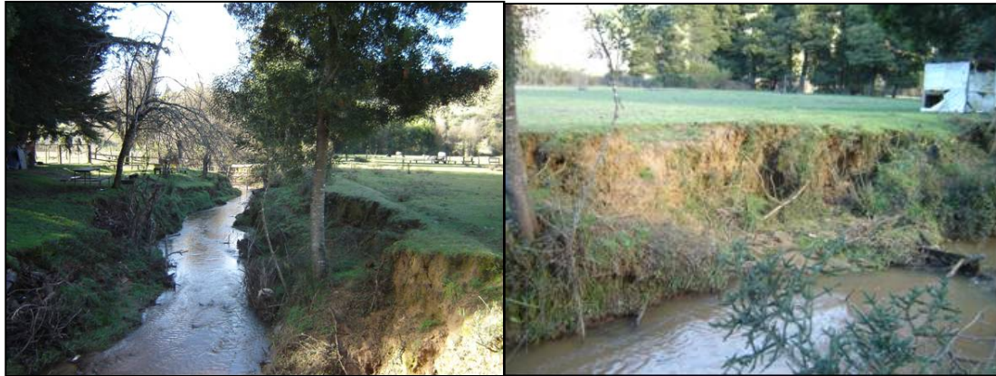
Figura 6: Situación Inicial del Talud
