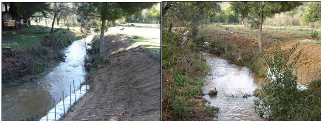
Figura 7: Situación Final del Talud
