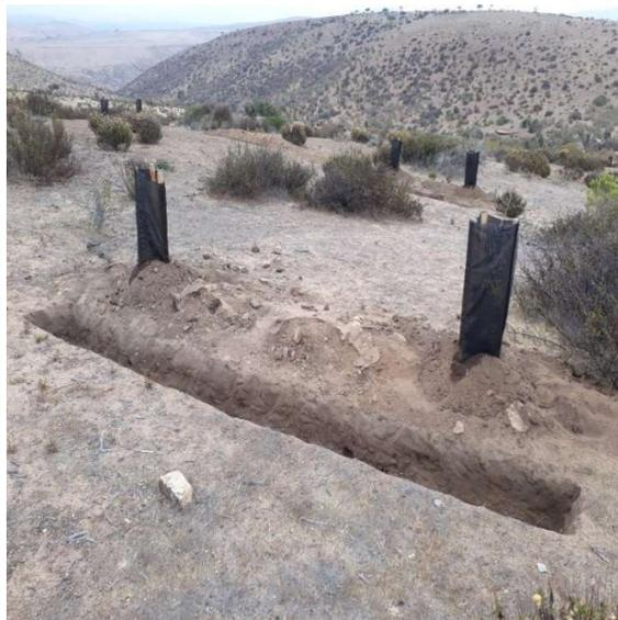
Figuras 3 y 4. Zanjas de infiltración
