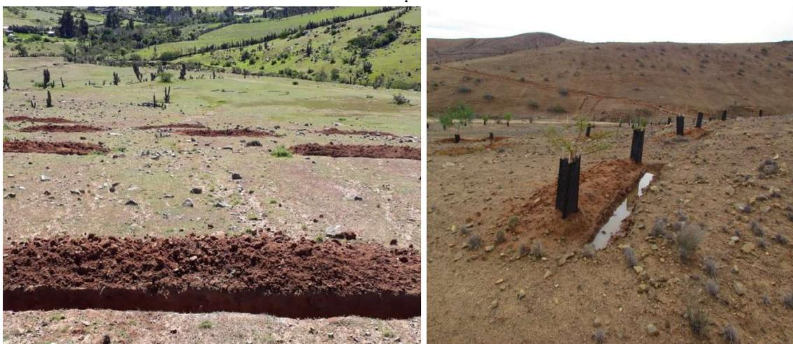
Figura N°4, Imagen Zanjas de infiltración
