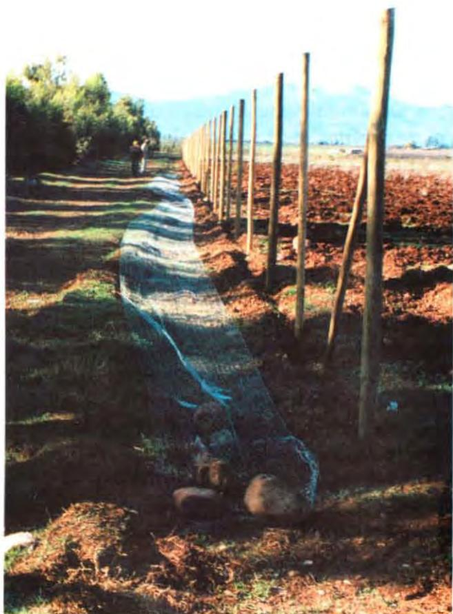
Figura 15: Instalación de cerco con malla ursus.
