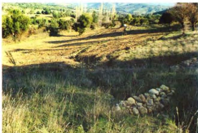
Figura 34: Construcción de diques de piedras para recuperar suelos erosionados, comuna de Curepto.
