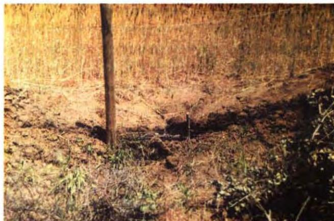
Figura 16: Confección de zanja para enterrar malla ursus en instalación de cerco.
