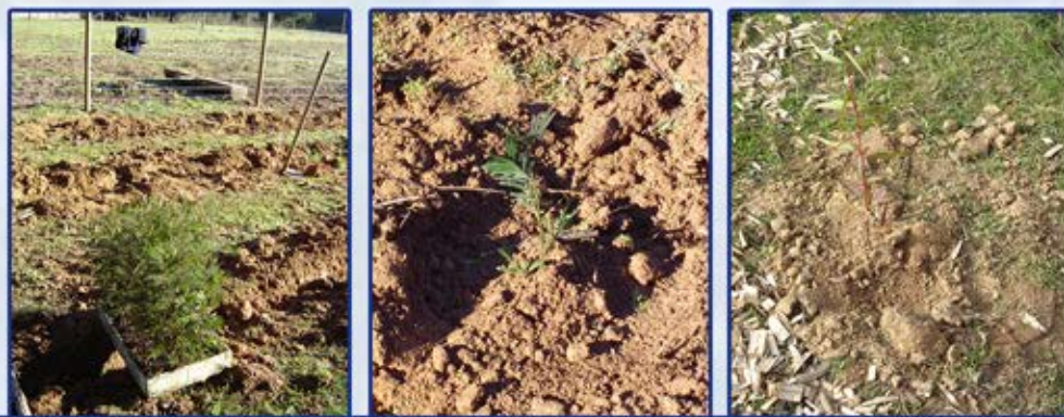
Figura N°23: PLANTAS EN CONTENEDOR; PLANTA DE Acacia dealbata EN CAMELLÓN Y PLANTA DE Eucalyptus camaldulensis EN HOYADURA
