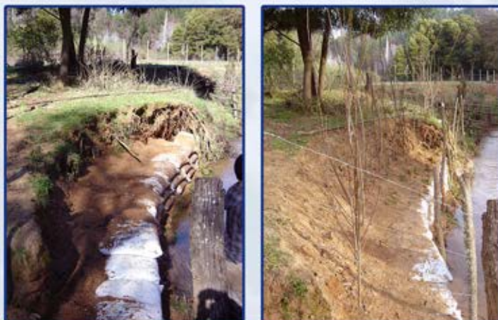
Figura N°22: ETAPA FINAL DE PROCESO DE ESTABILIZACIÓN DE TALUD CON DIQUES Y ESTABLECIMIENTO DE VEGETACIÓN
