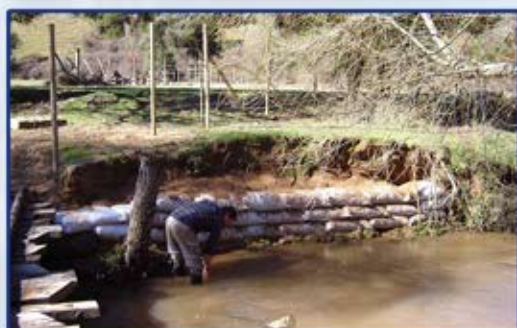
Figura N° 21: ESTABILIZACIÓN DE TALUD Y PROTECCIÓN DE PUENTE CON DIQUES
