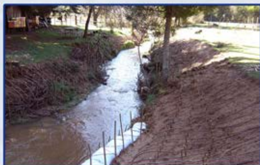
Figura N° 20: PROCESO DE ESTABILIZACIÓN DEL TALUD
