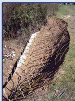
Figura N°26: ENTRAMADO CON Salix sp. EN TALUD ESTABILIZADO, DE MANERA PERPENDICULAR (IZQ.) Y PARALELO AL CAUCE (DER.)
