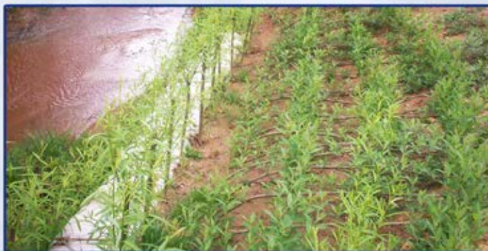
Figura N°7: ESTABILIZACIÓN DEL TALUD CON COBERTURA VEGETAL Y DIQUE DE CONTENCIÓN CON SACOS
