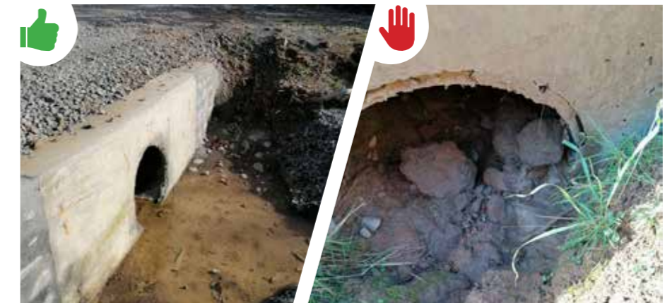
Alcantarilla sin obstrucción.
