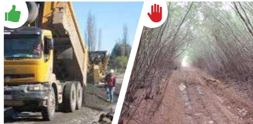
Faena de construcción de caminos.
