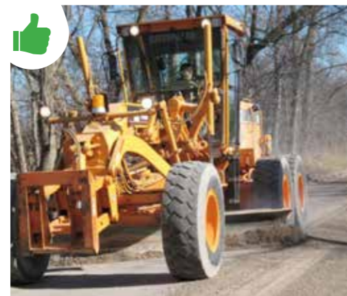
Mantención de perfilado del camino.
