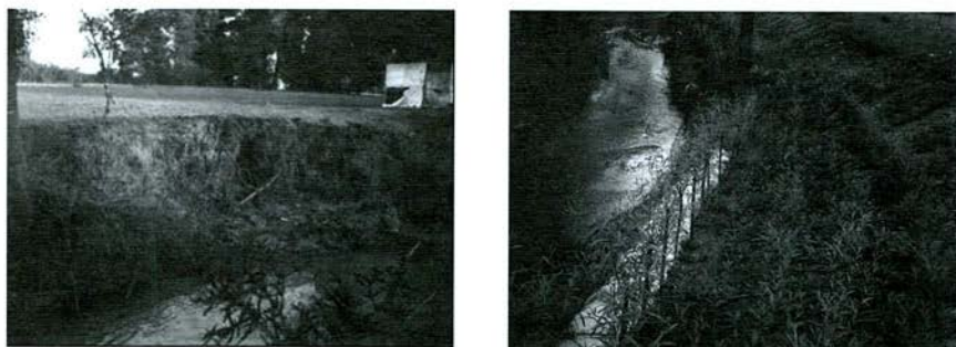
Figura 4. Cauce degradado sin protección (izq); cauce tratado con protección física y plantación en el talud (der).
